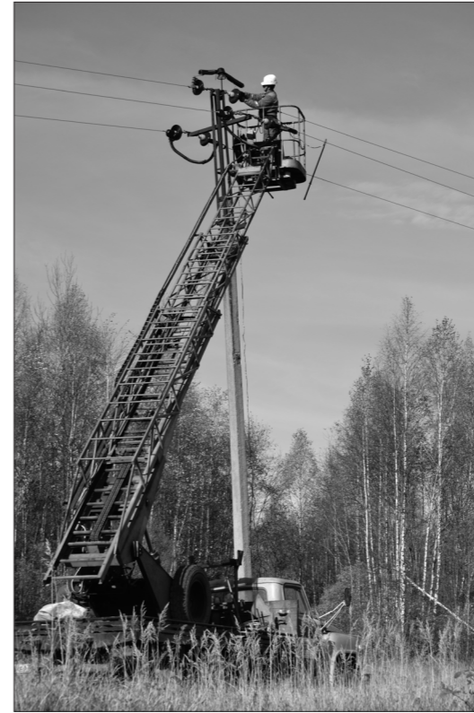
Рис. 3. Оснащение птицевозащитными устройствами ВЛ 10 кВ. Фото автора
